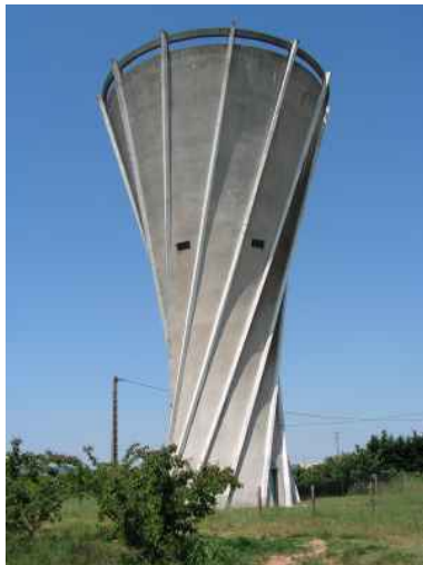
Un château d'eau
