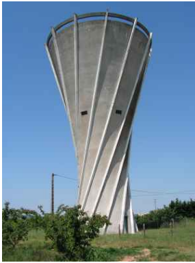
Un château d'eau
