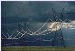
Lignes à haute-tension
