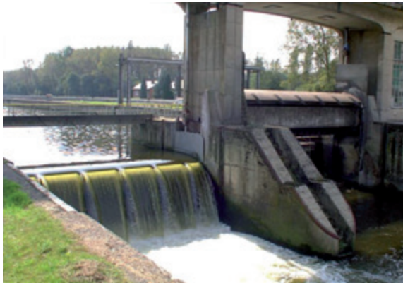
Figure 5 : Vannes mobiles pour la régulation des canaux. A droite, la vanne a été sortie de l'eau pour une opération de maintenance.
